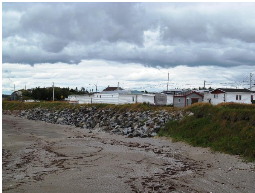
Figure 2 : enrochement localisé à Shelldrake
